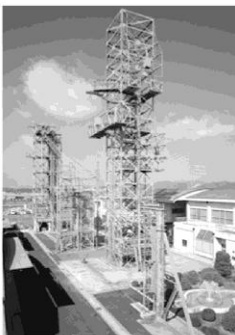
屋外試験鉄塔群
